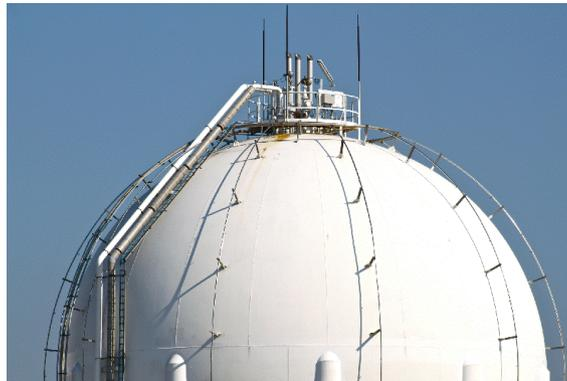
**Figura 6.23:** Vaso de pressão esférico de armazenamento de gás.
