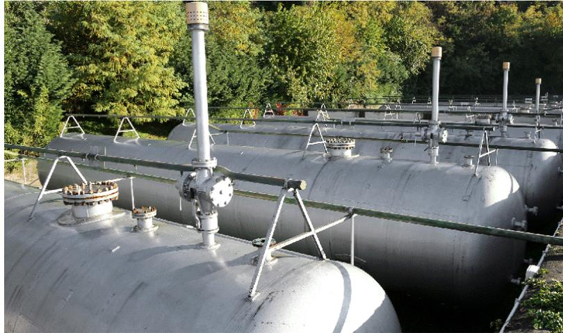
**Figura 6.19:** Vasos de pressão cilíndricos de armazenamento de gás.
